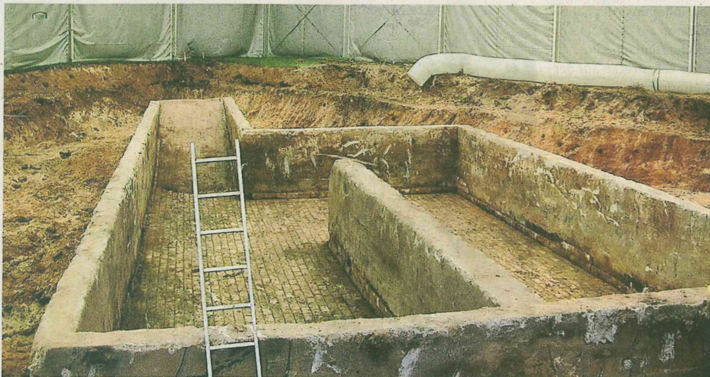
Das Bild zeigt ein früheres Klärbecken der DAG, das bei einer Sanierung im Jahr 2003 ans Licht kam.
