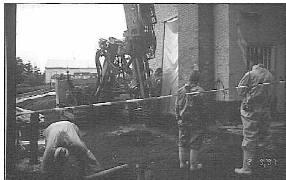
Injektionen zur Stabilisierung des Baugrunds
