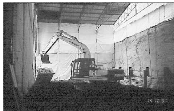
Sanierungsarbeiten in Zelten
