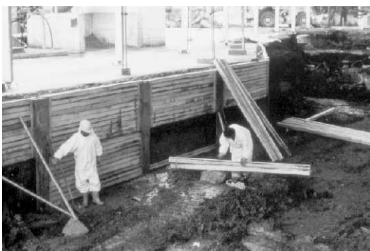
Gebäudesicherung durch Trägerbohlwände
