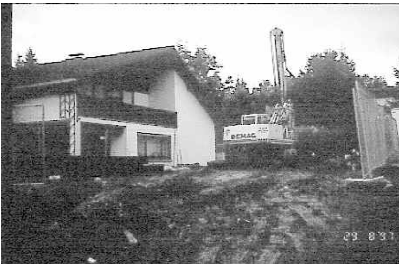
Sanierungsarbeiten im 1. Sanierungsteilraum
