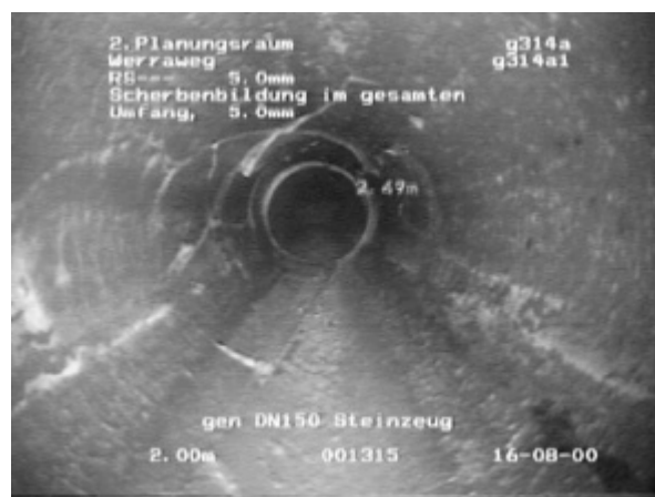
Momentaufnahme der Altkanalinspektion
