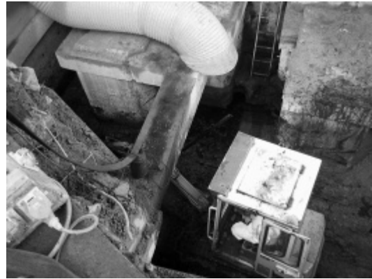
Räumung mit Minibagger
