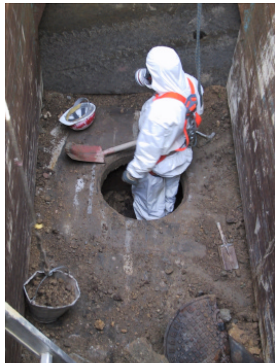
Bergung von Sprengstoff
