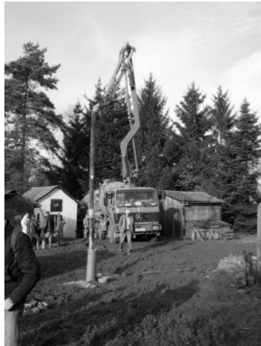
Verdämmung stillgelegter Kanäle
