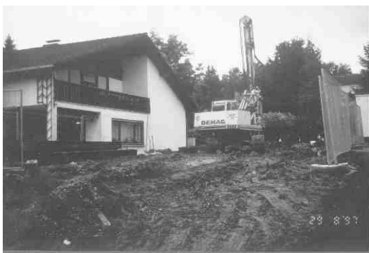
Vorarbeiten Baugrubensicherung
