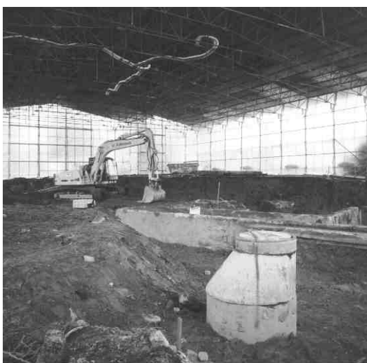
Bodensanierung unter provisorischer Zeltüberdachung
